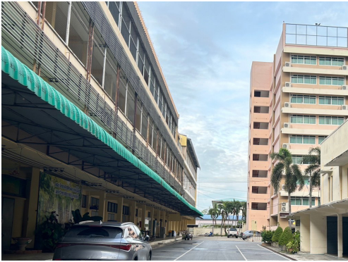
เคยขุดพบพระพุทธรูปขณะขุดหลุม สร้างอาคารคณะวิทยาศาสตร์และ เทคโนโลยี (อาคารซ้ายมือ)
